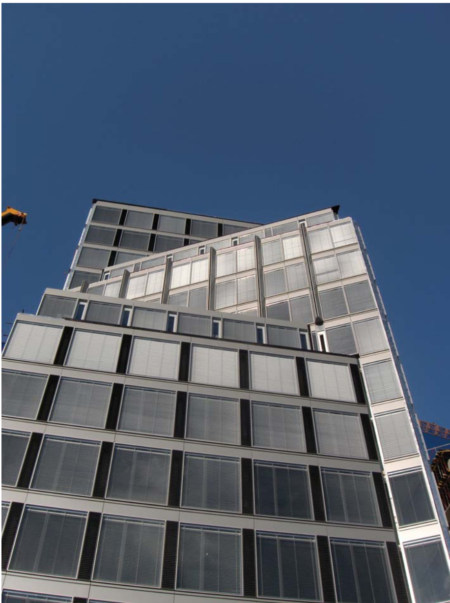
Verwaltungsgebäude, Sofia, Arch. Dimitar Pascalev Tageslichtplanung Köster Lichtplanung, Frankfurt/Sofia
